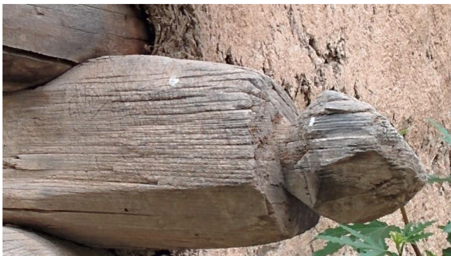
برش ایجاد شده در یک سر تیرها برای حمل آنها با طناب از جنگل به روستا
