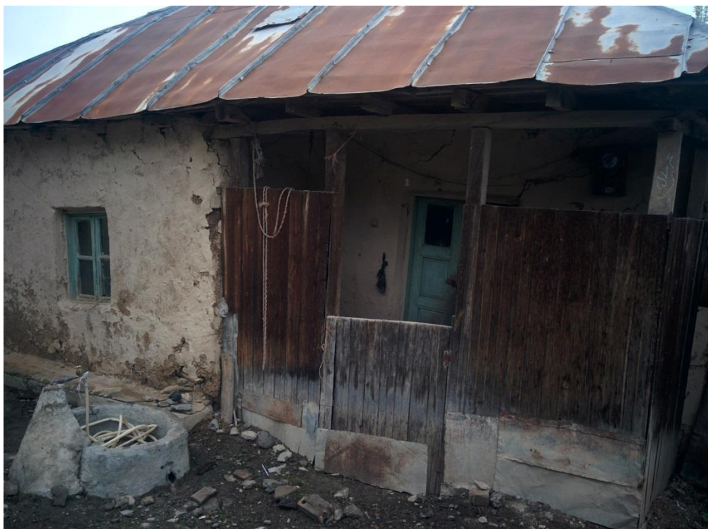
(سقف حلبی به جای لت یا تخته چوب، از تغییرات ایجاد شده در خانه‌های نیمه سنتی است.)
