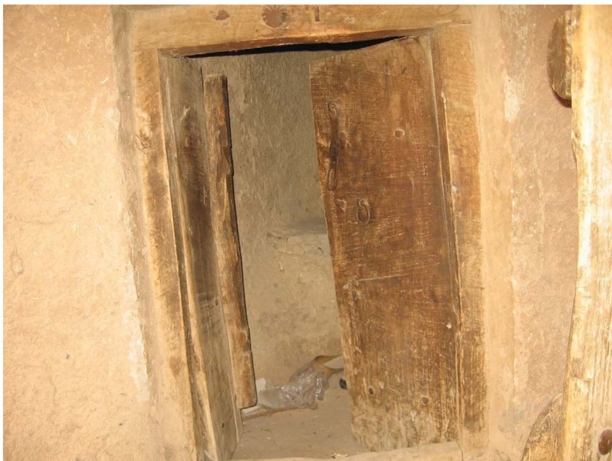
نمای نزدیکتر در ورودی برج از داخل خانه روستایی
