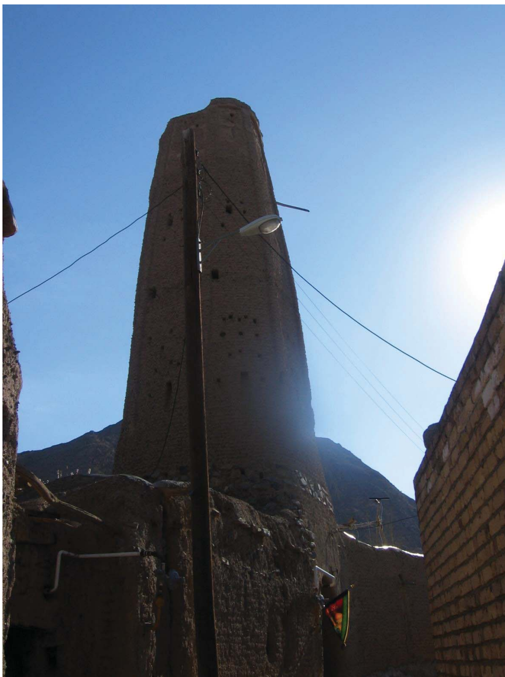
نمای برج از کوچه و در مقیاس با تیر چراغ برق
