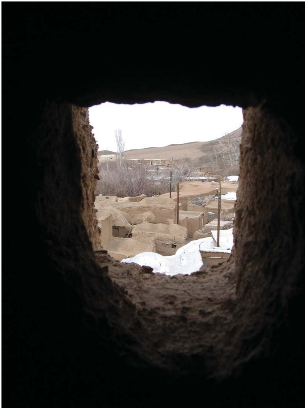
نمای یکی از سوراخ‌های بزرگ شلیک در طبقه دوم برج با نمای بازتر برای شلیک دورتر، نمای روستا از داخل سوراخ شلیک قابل مشاهده است. بدون نور فلاش
