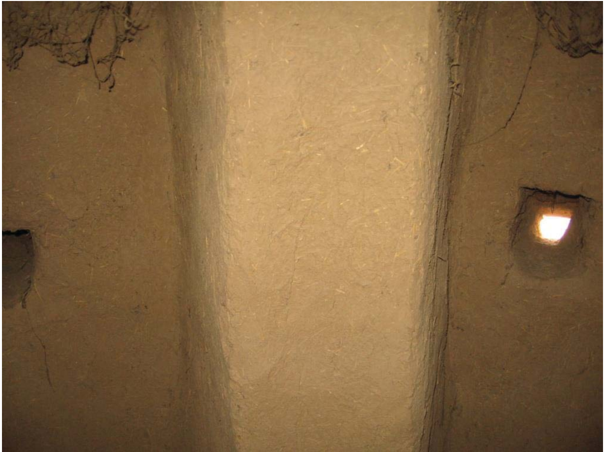
یکی از ستون‌های برج در طبقه اول و سوراخ‌های شلیک با نور فلاش
