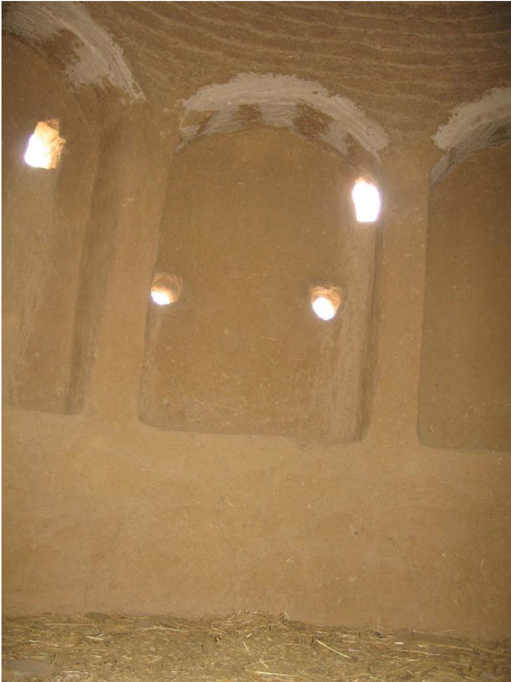
بدنه، ستونها و بخشی از سقف طبقه اول برج با نور فلاش، بخشی از تاق گنبدی و تعدادی از سوراخ‌های شلیک قابل مشاهده است.
