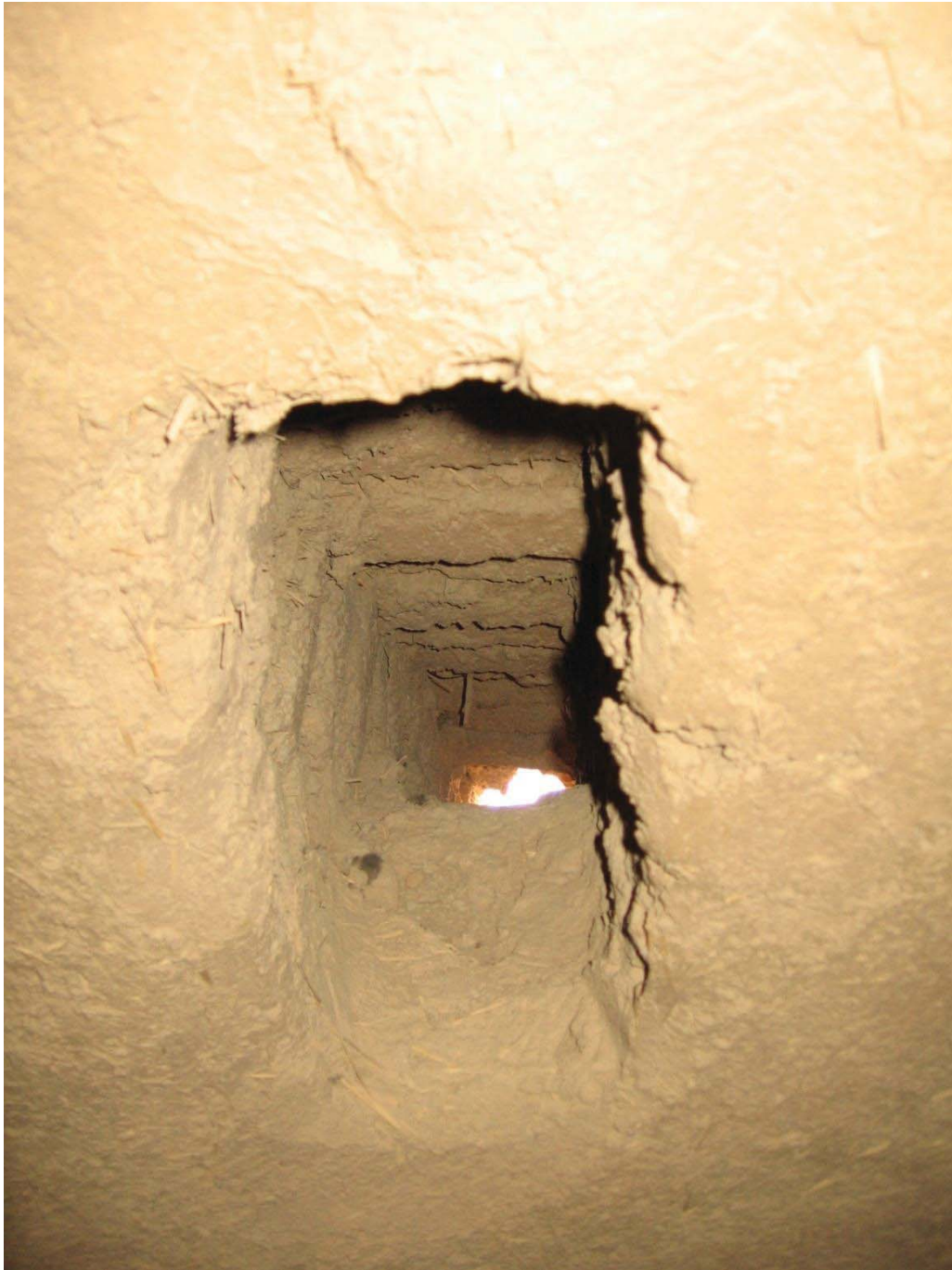
نمایی از یک سوراخ با زاویه پایین رو به کوچه برای شلیک با تفنگ در طبقه اول با نور فلاش
