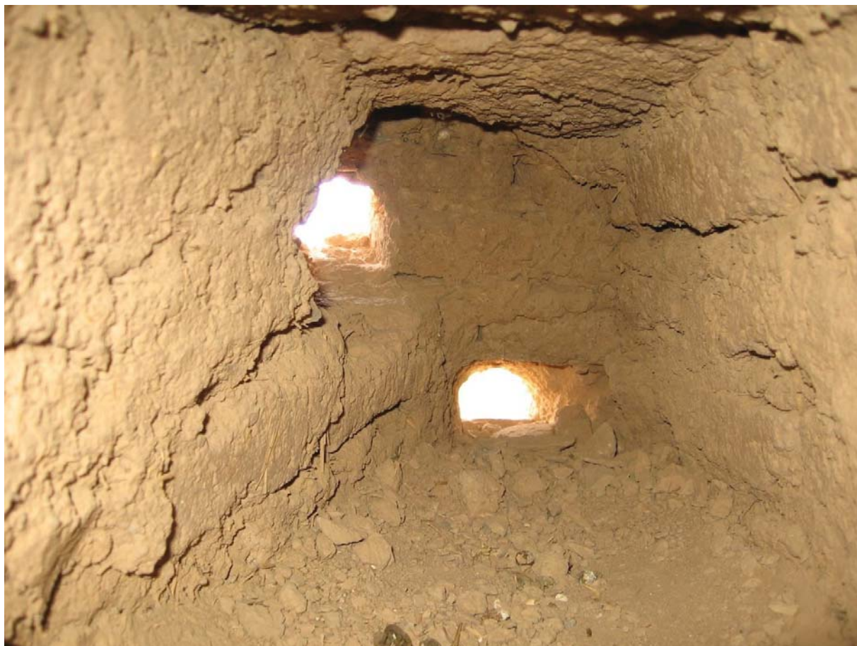
نمایی از سوراخ‌های دوتایی شلیک در طبقه اول با زاویه باز و نور فلاش
