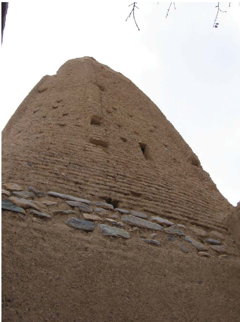
نمای برج از کوچه و استحکامات سنگی آن
